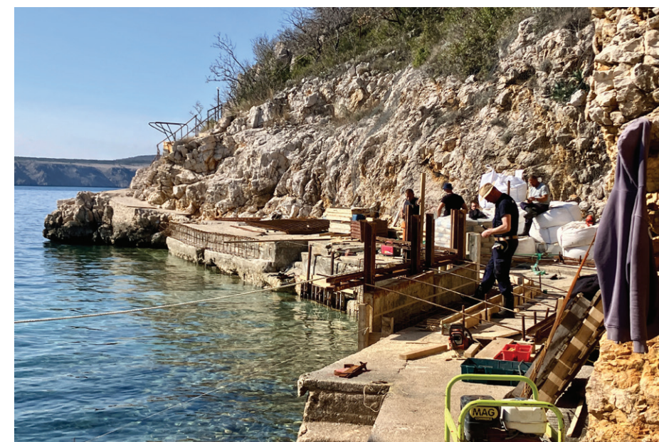
Raspucale betonske ploče sunčališta već su uklonjene te je započela sanacija platoa
